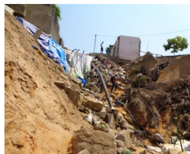
Fig.20 : Mauvais drainage des eaux des pluies occasionnant le ravinement des avenues
